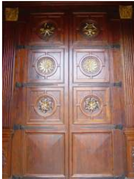
Porta central de doble full que dóna accés a la nau principal de l'església.
